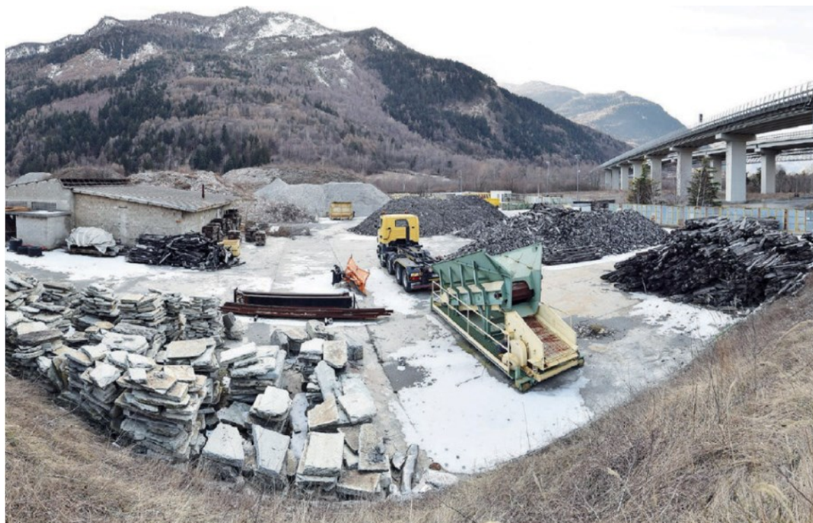
Cantieri Quelli del Tav in Val di Susa (accanto Salbertrand) in Italia sono fermi di fatto da 10 anni FOTO ANSA
